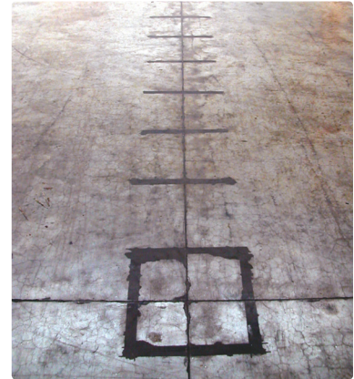
Sanierung eines Fugenschnittes durch nachträgliche Verdollung.
