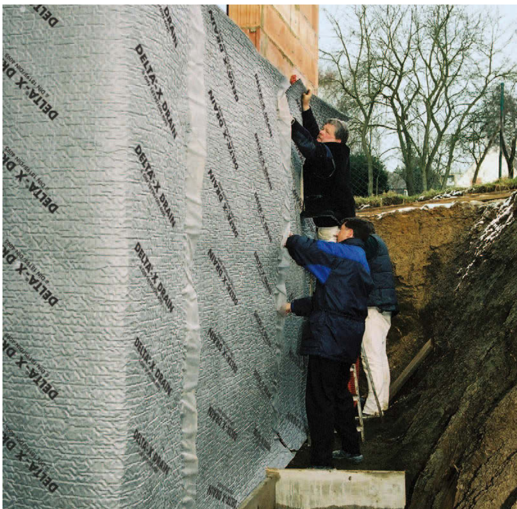
DELTA®-X DRAIN – als kompakte Einheit in einem Arbeitsgang schnell zu verlegen.
