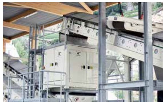
Die eingesammelten Gipsabfälle werden in unserem RiCycling® Werk zu wertvollem Rohstoff für die Alba® Plattenproduktion aufbereitet.
