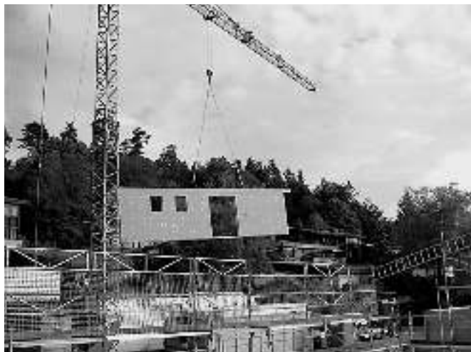
Montage vorgefertigter Bauteile; Holzrahmenbau
